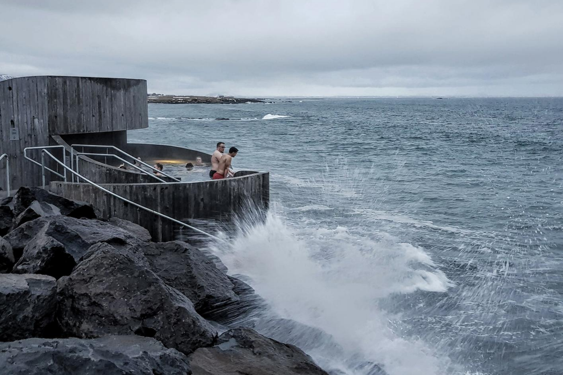
Guðlaugi basseinid Akraneses, Islandil. Valmis 2018. Arhitektuur: Basalt. Foto: Magnús Aðalmondsson.
