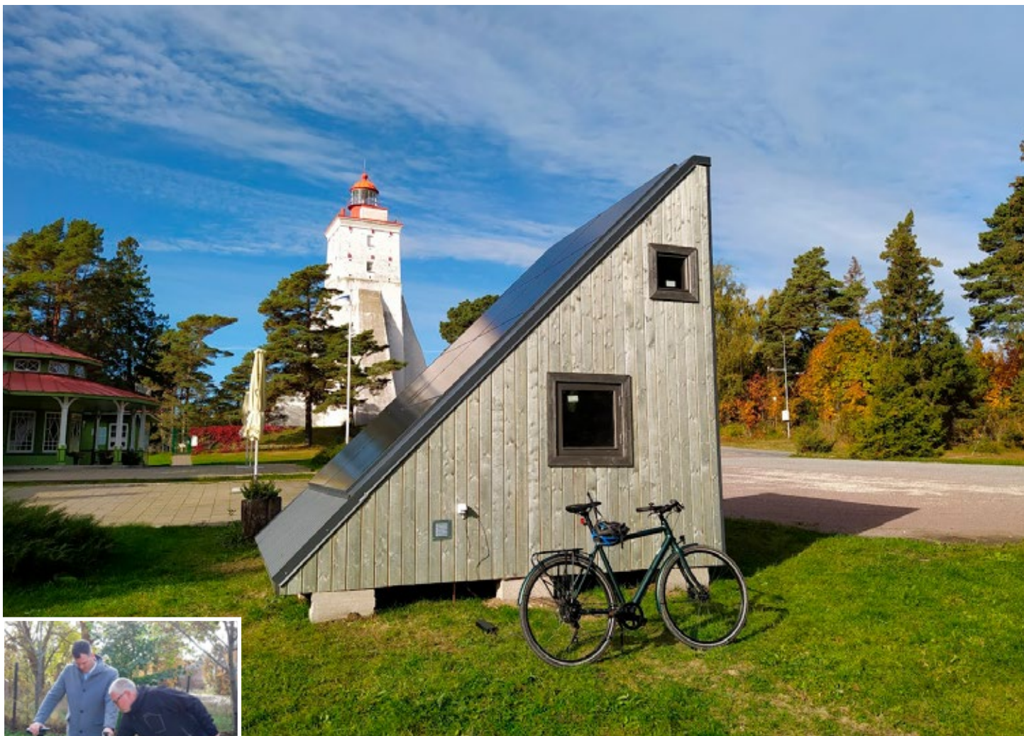
Kolmas Trian S paviljon, kus elektrijalgrattaid päikeseseenergiaga laadida saab, sai valmis Kõpus. Lisaks on sellised Heltermaa sadamas ja Kõrgessaares. Foto: Peep Lillemägi
