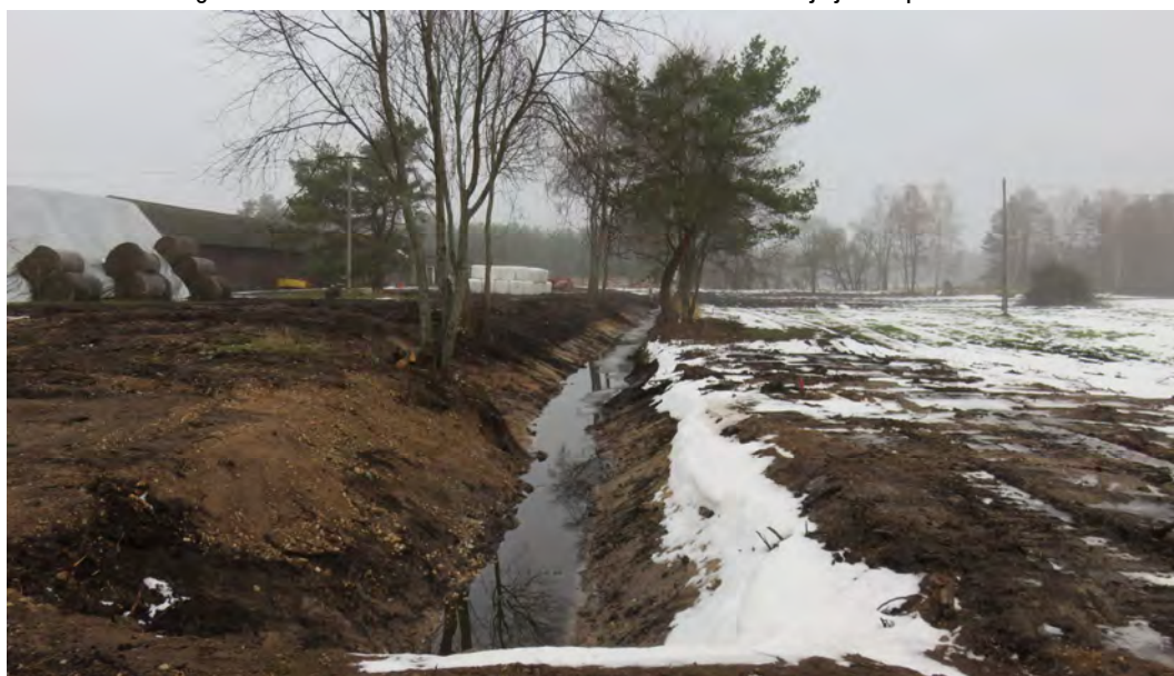
FOTO 3: Vaade Pulli ja Lauda kinnistute vahelisele kuivenduskraavile.
