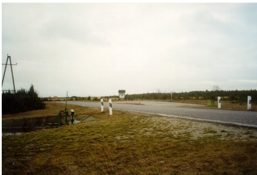
Foto 1. Orjaku üks ühendussildadest, millele on paigaldatud Käina lahe veerežiimi reguleerimiseks vastavad regulaatorid
